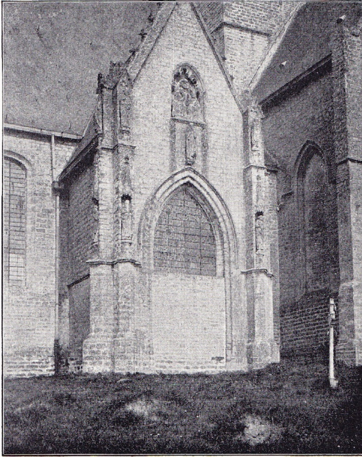
HULDENBERG — L'ancienne entrée de l'église
